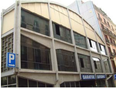
001 pàrquing abans enderroc.1.JPG
