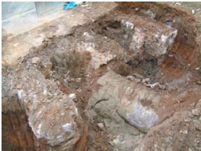
015 dipòsit combustible sector 5000.1. ...
