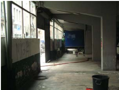
001 pàrquing abans enderroc.4.JPG
