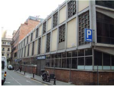
001 pàrquing abans enderroc.2.JPG
