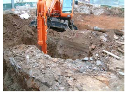
014 treballs sector 5000.1.JPG
