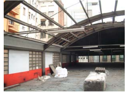
001 pàrquing abans enderroc.3.JPG
